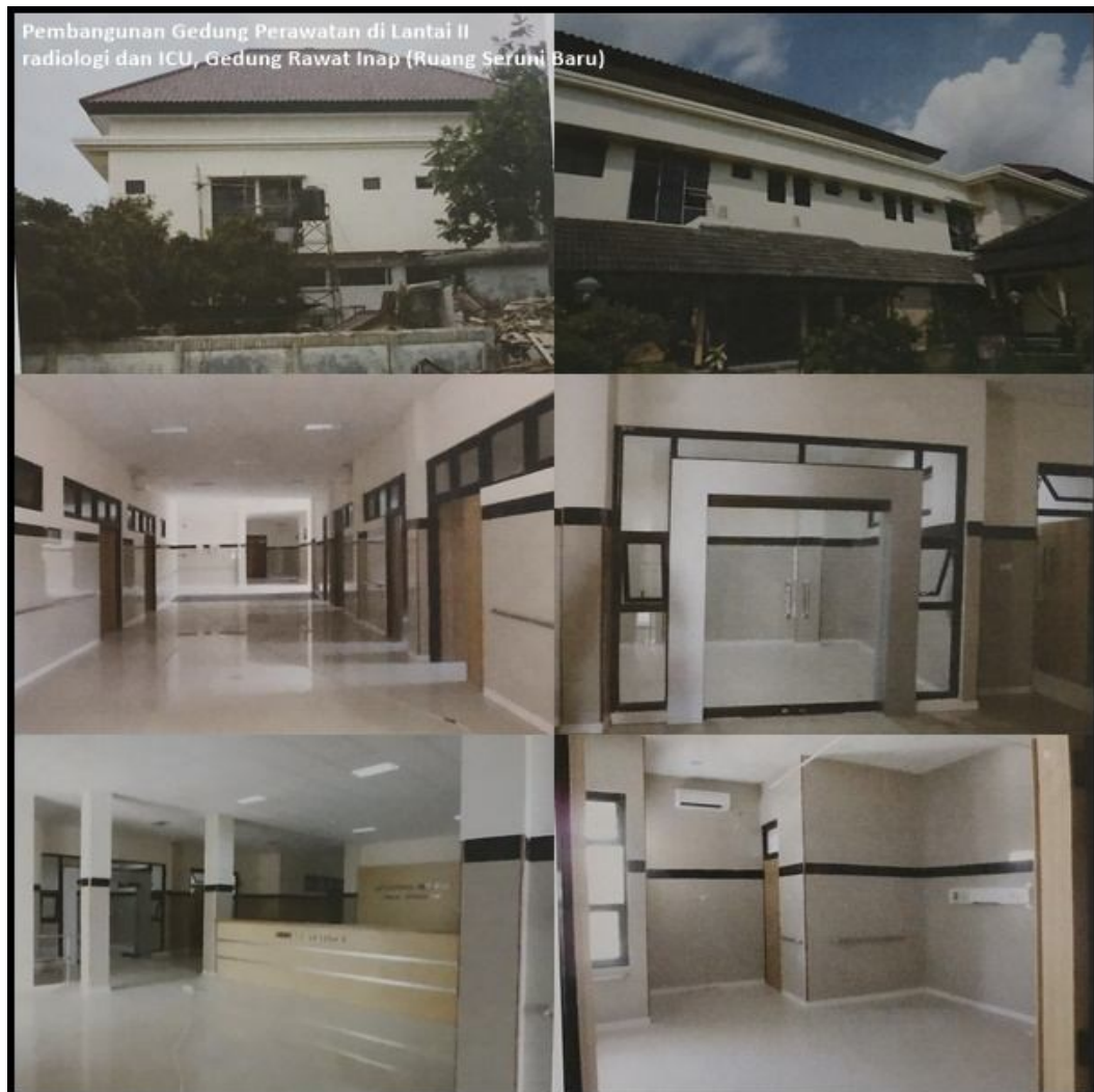
Gambar 4.1 Pembangunan Ruang Seruni Baru RSUD Muntilan Tahun 2018
